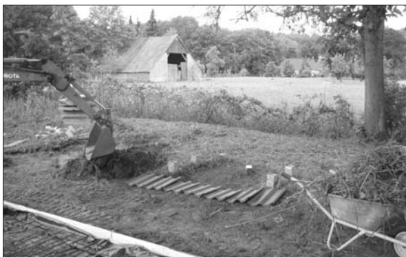
11. ... und wenig später ist der Bagger da.
